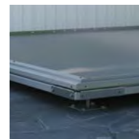
Niwelacja za pomocą regulowanych stóp
