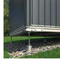
Niwelacja za pomocą wkrętów gruntowych
