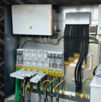
Instalacja Trafostacji Trafostation installation
