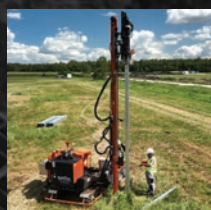
Palowanie i grodzenie Piling and fence installation
