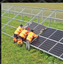
Montaż konstrukcji Structure assembly
