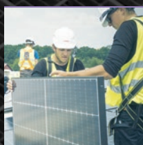
Montaż modułów Module installation
